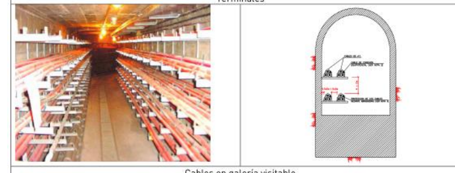
Cables en galería visitable
